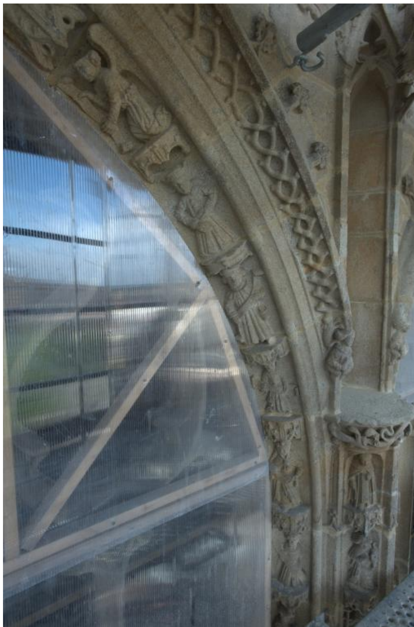
Portail nord. Vousures en cours de restauration
