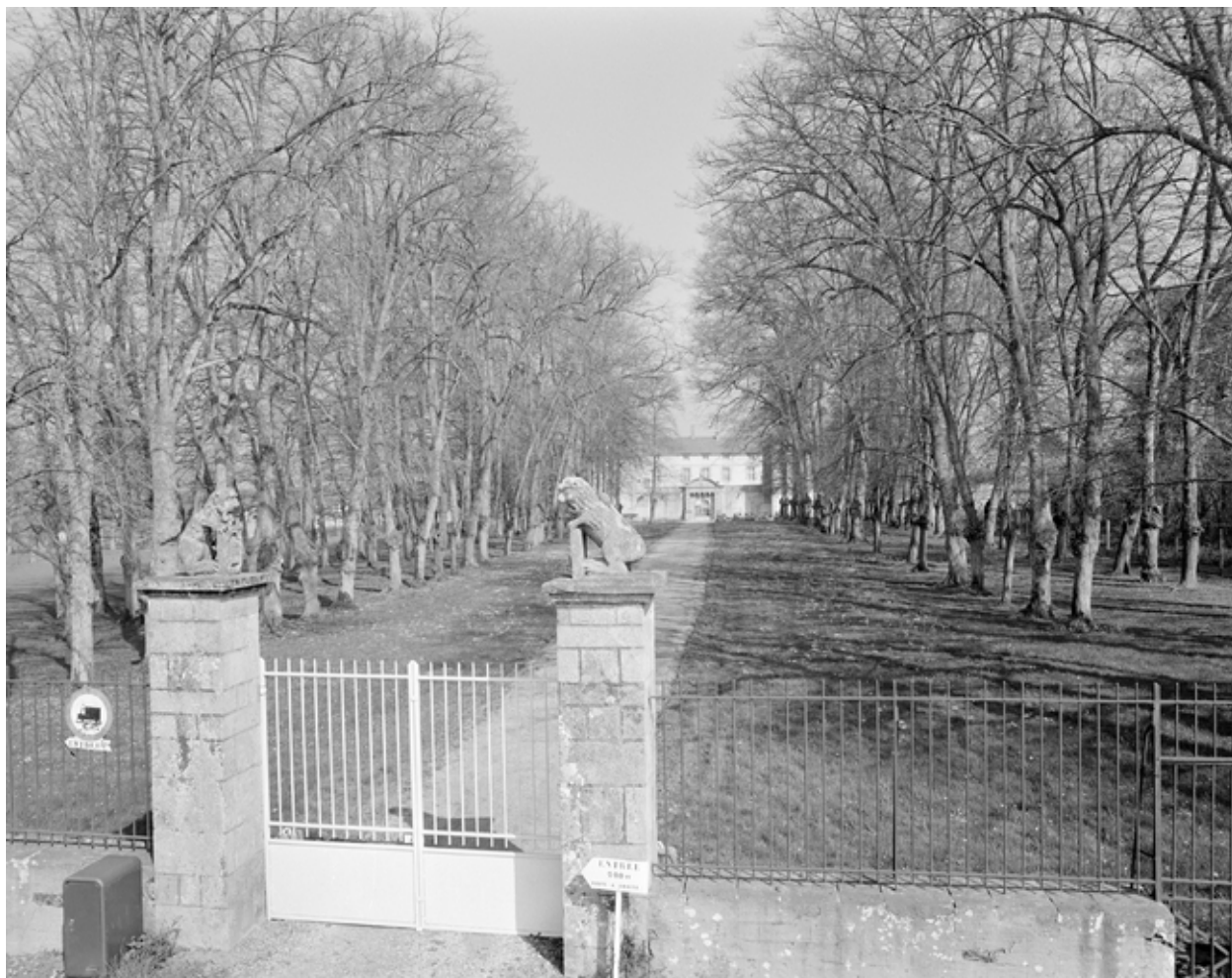
Portail : vue générale
