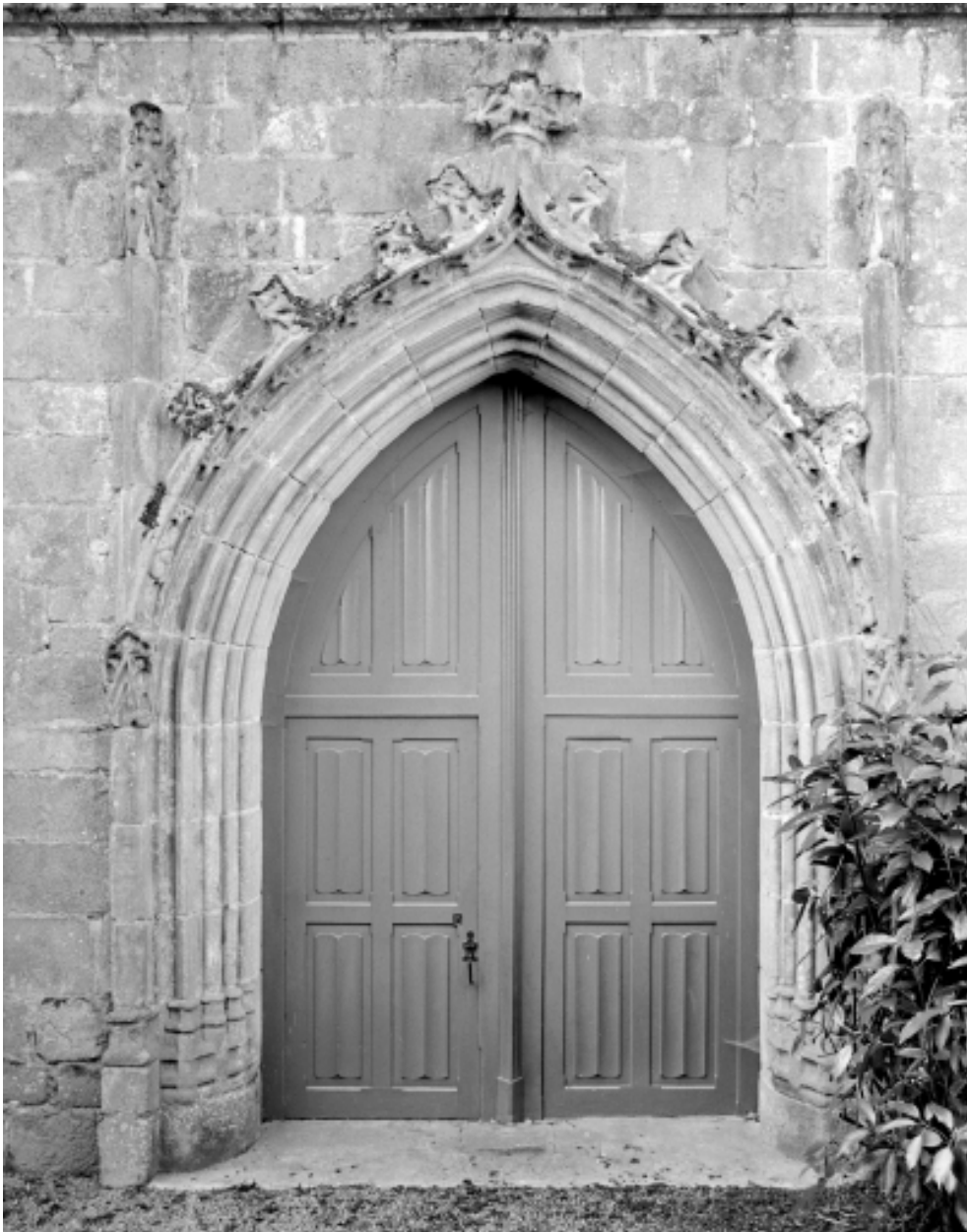
Porte : vue générale
