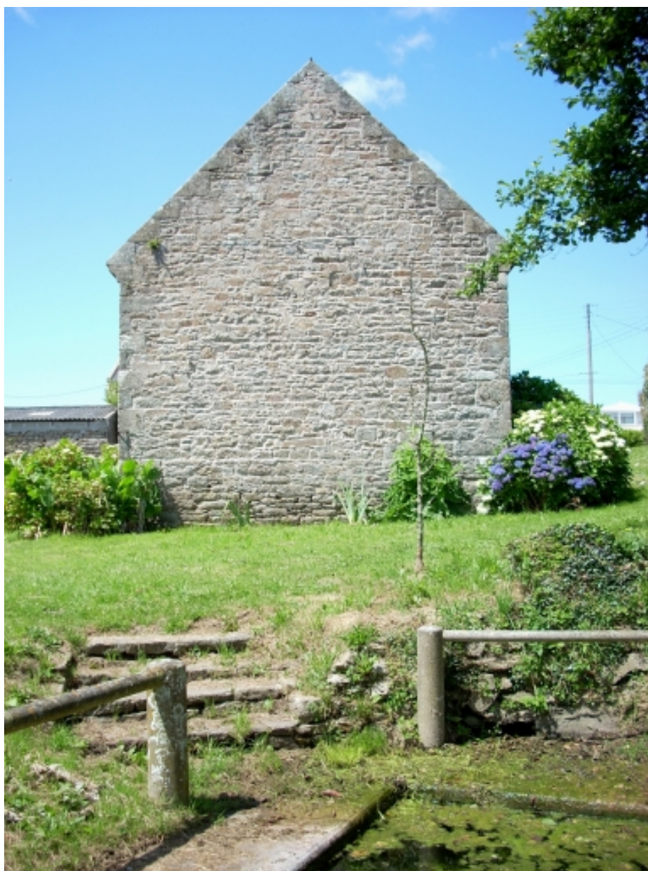
Ploudalmézeau, chapelle Saint-Eloi : élévation est
