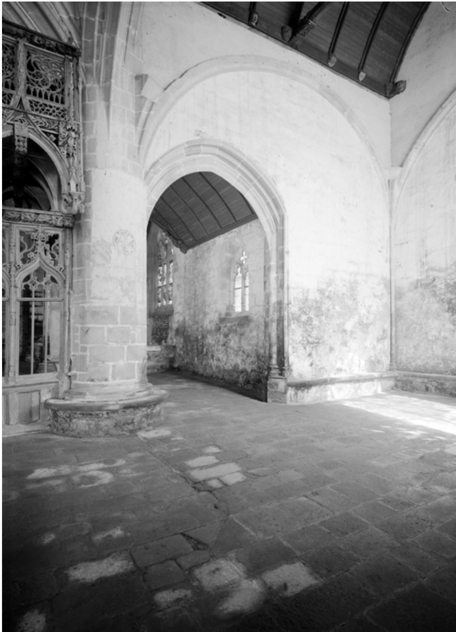
Arc diaphragme du bas-côté nord.
