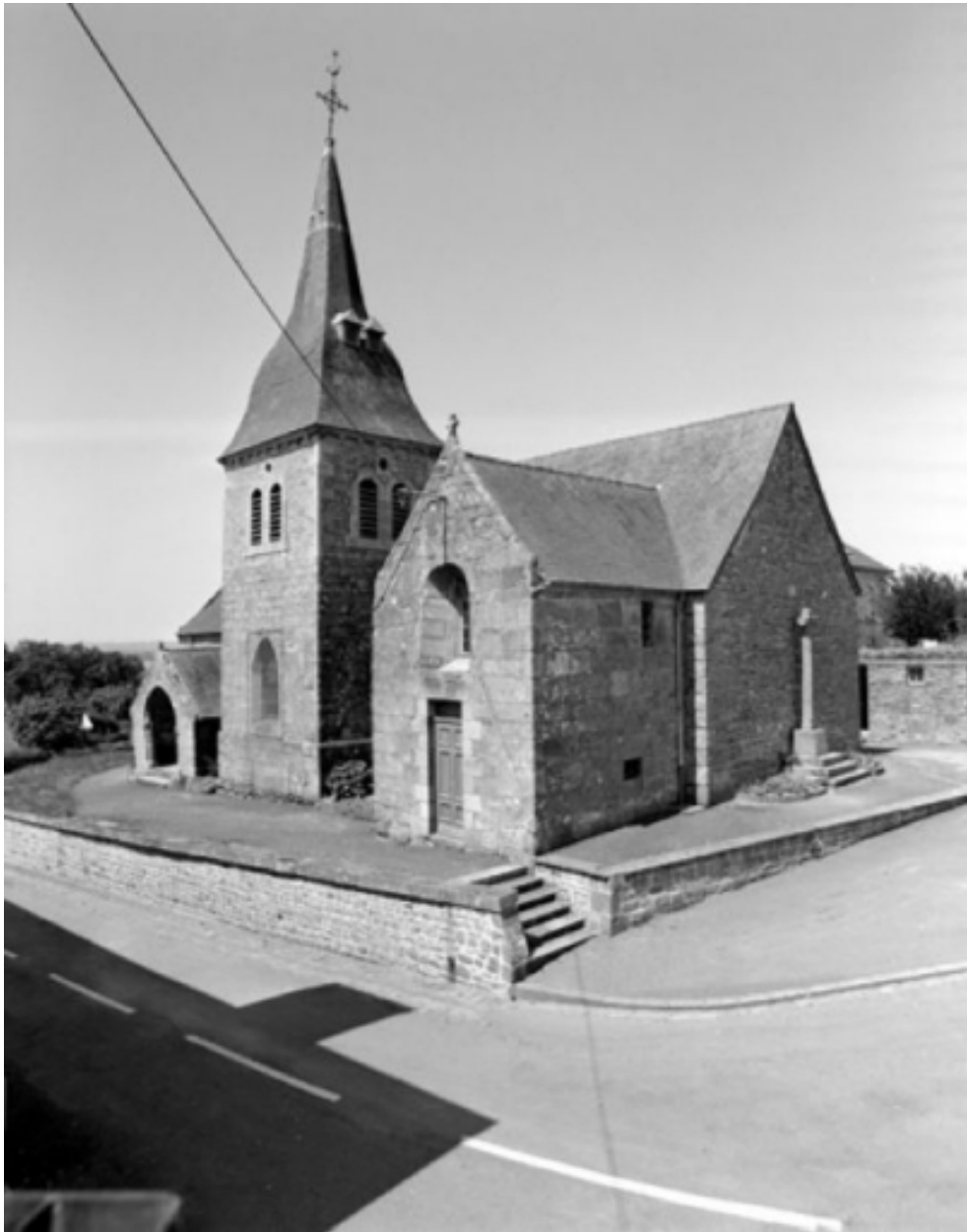
Elévation Sud-Est : vue générale
