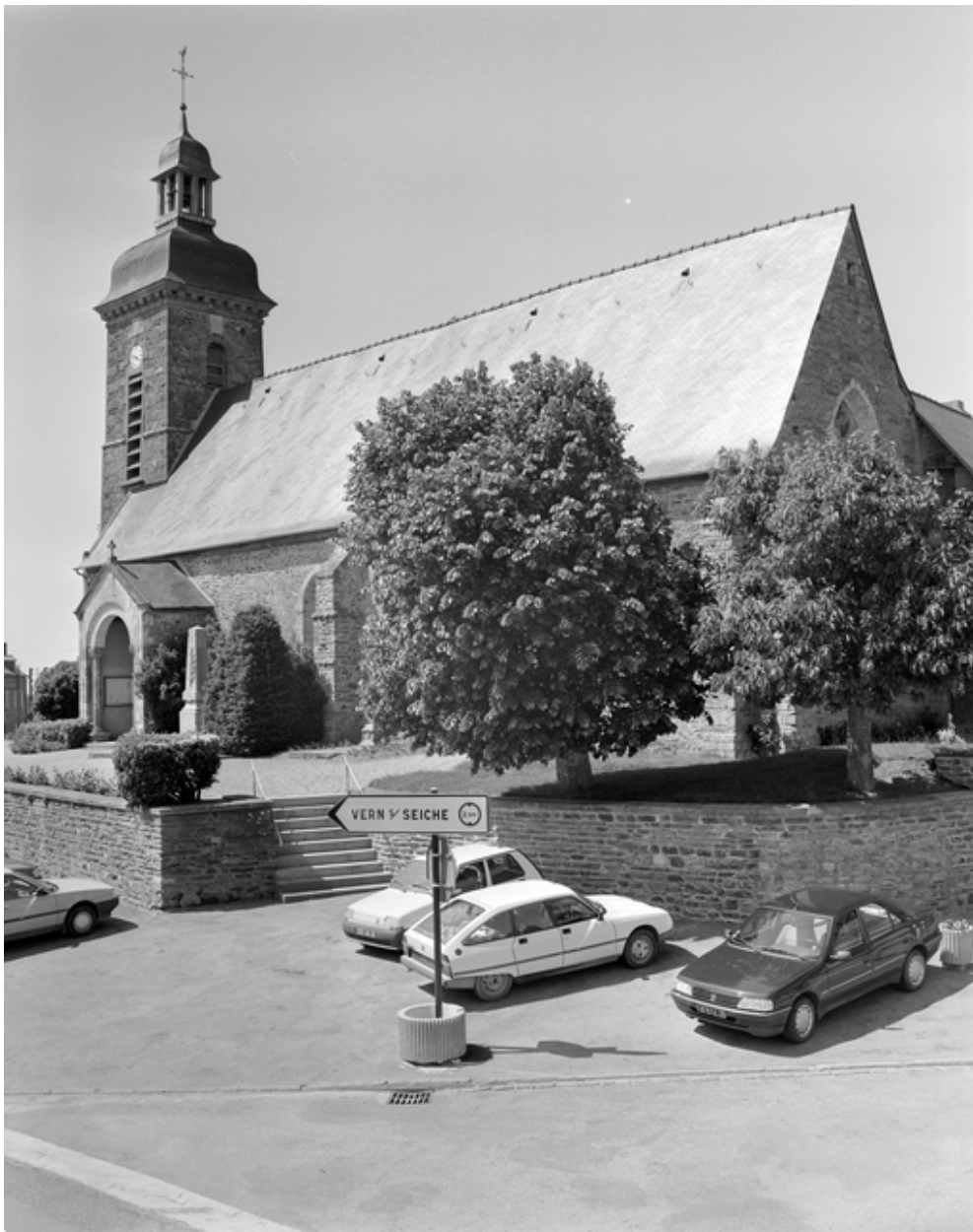
Elévation Sud : vue générale
