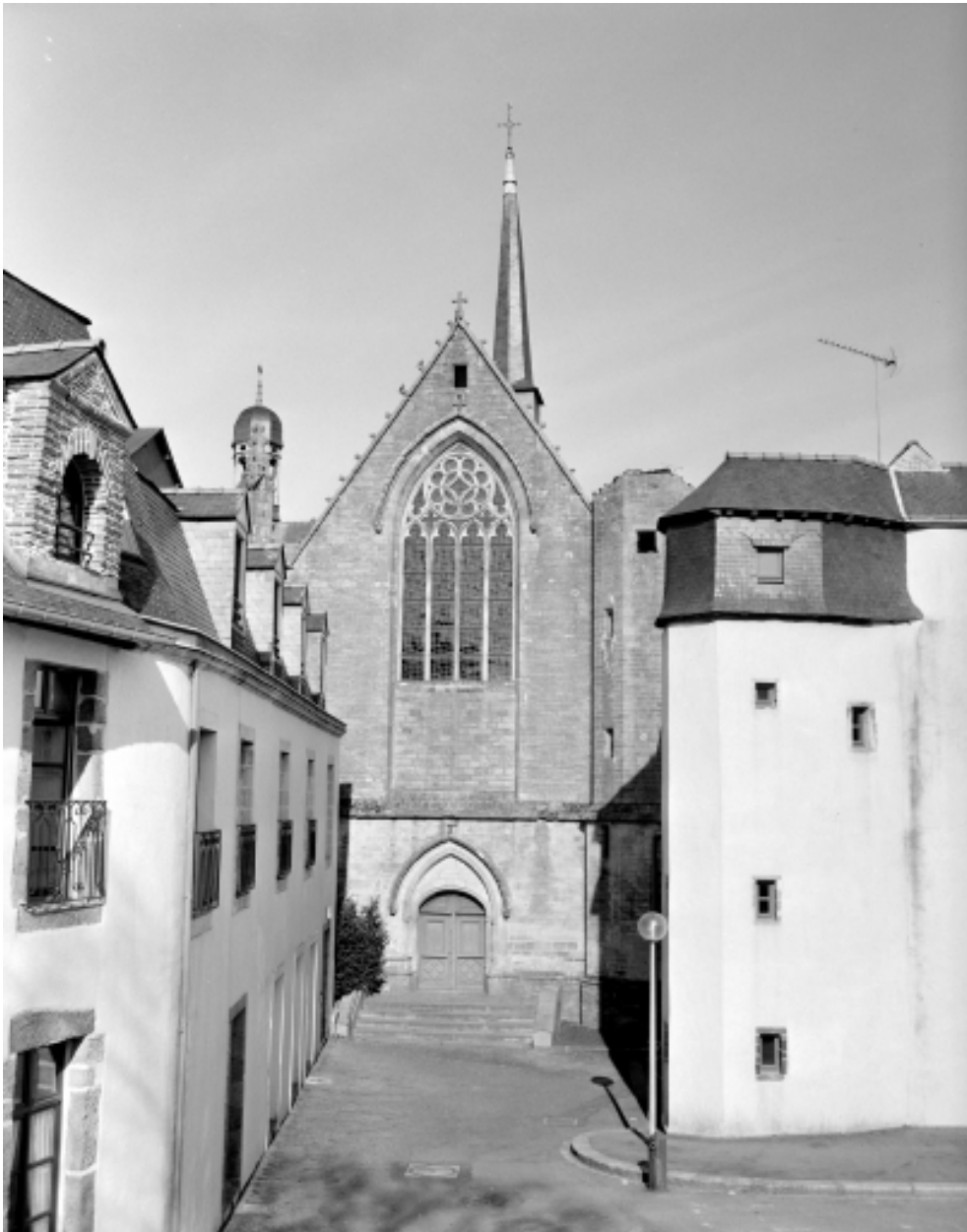
Elévation Sud : vue générale
