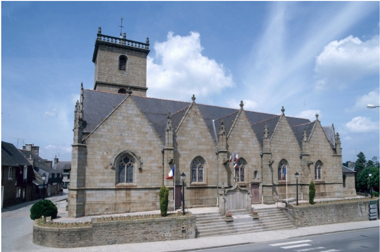
Elévation Sud : vue générale
