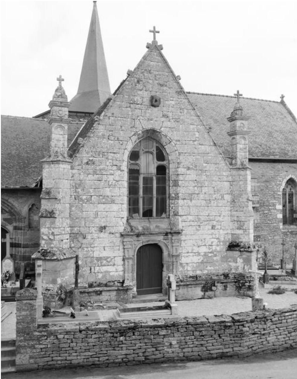
Chapelle, bras sud du transept : élévation sud (état en 1991)
