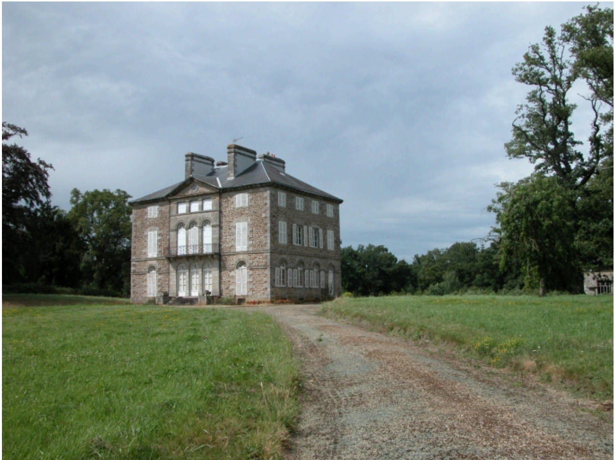
Château, vue générale sud
