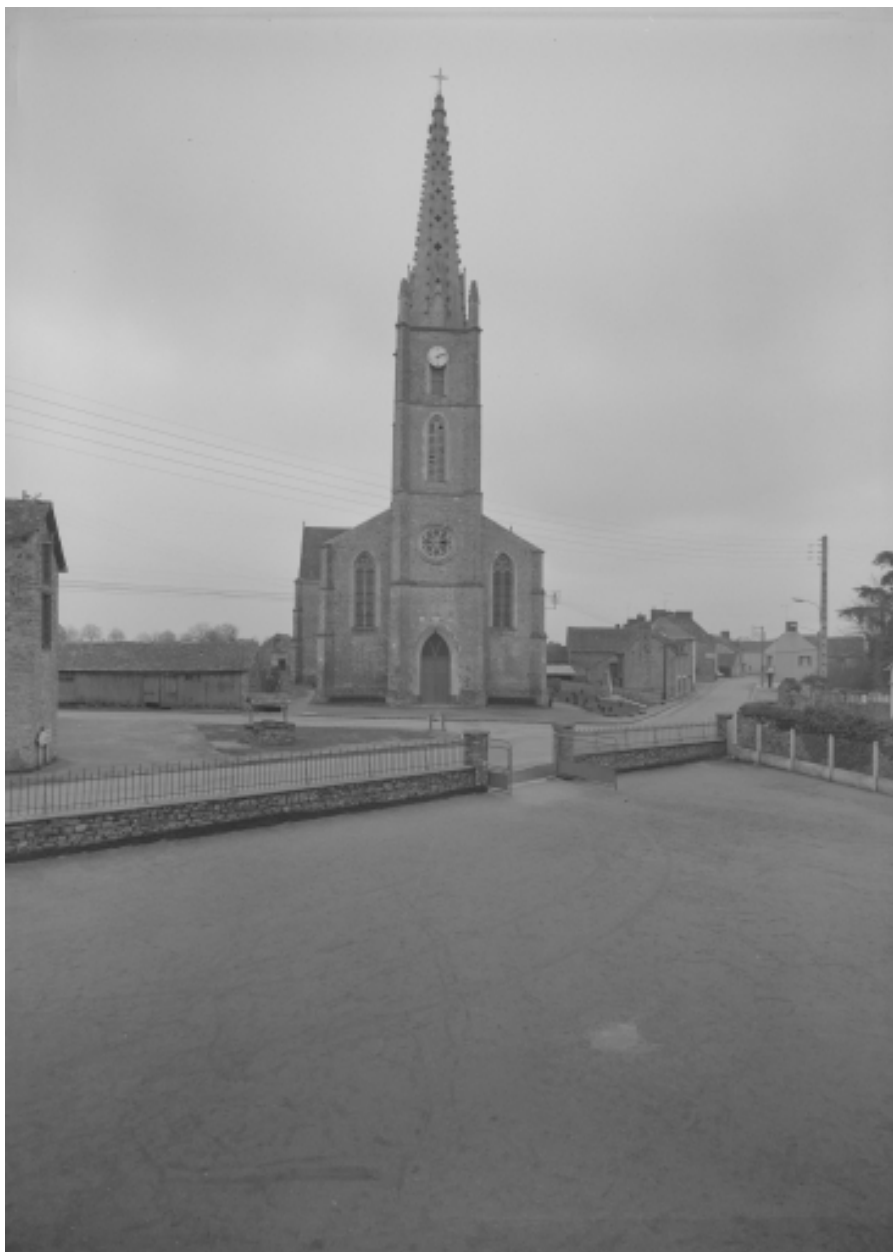
Elévation ouest : vue générale
