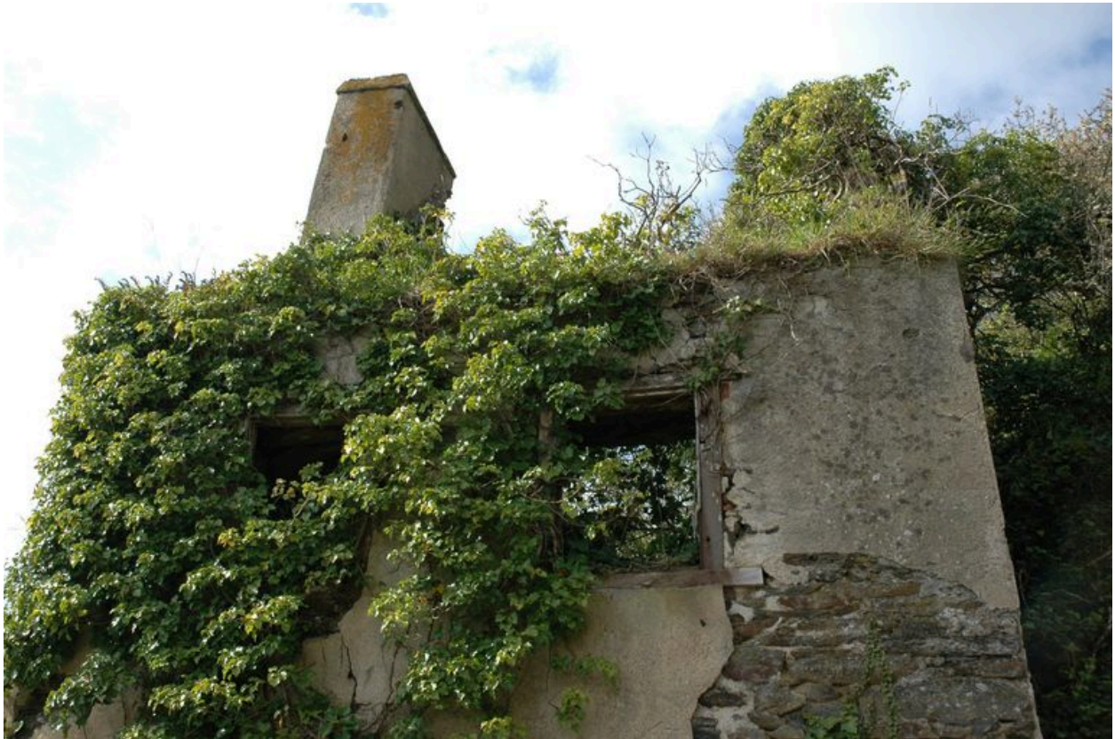
Vue de la pointe des Espagnols : la batterie basse et ses casernements ruinés (18 e siècle)
