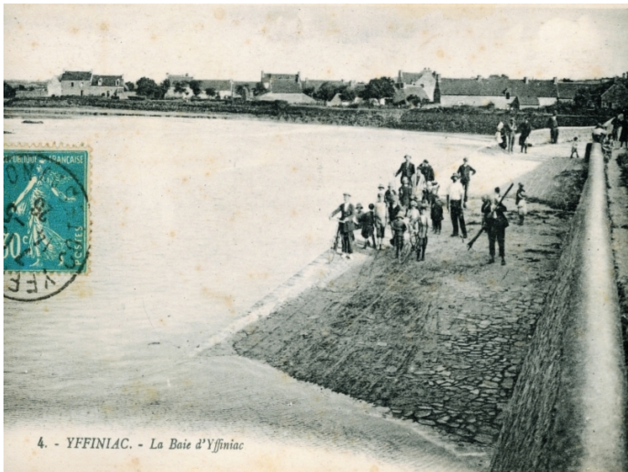
Rampe ou cale d'accès à la mer de Ruzé-Bréha (1910)
