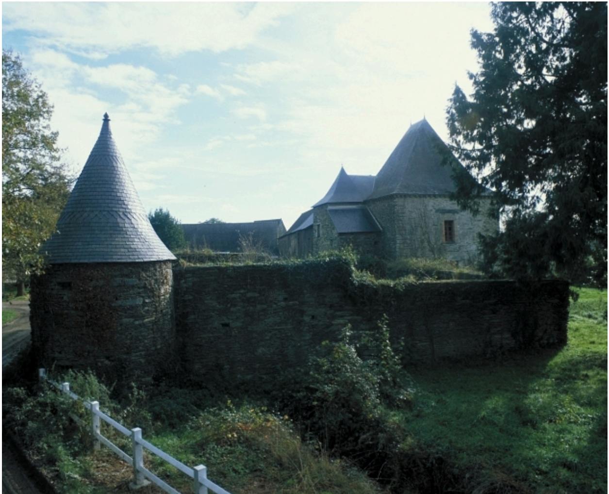
L'ancien manoir et ses douves : vue générale nord
