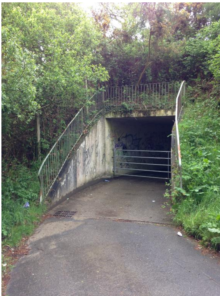
Tunnel d'accès à la piste
