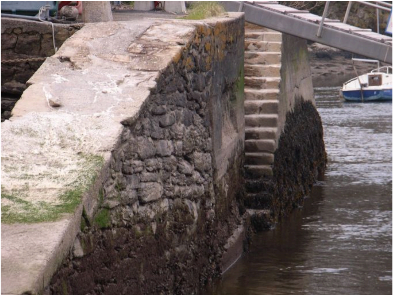
Rampe et escalier au bout du quai Polignac
