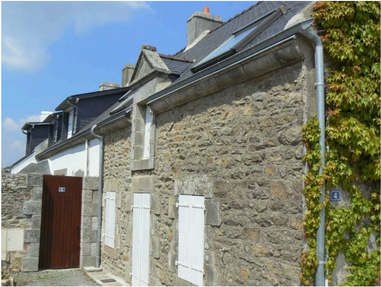
Maison de pêcheur du 4 rue de la Pointe du Bill
