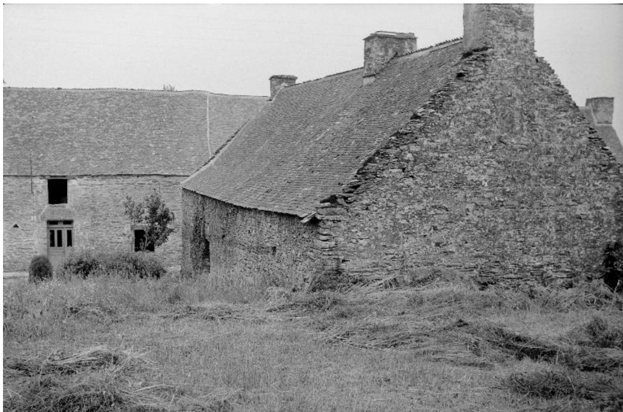
Ferme 27 (état en 1969)
