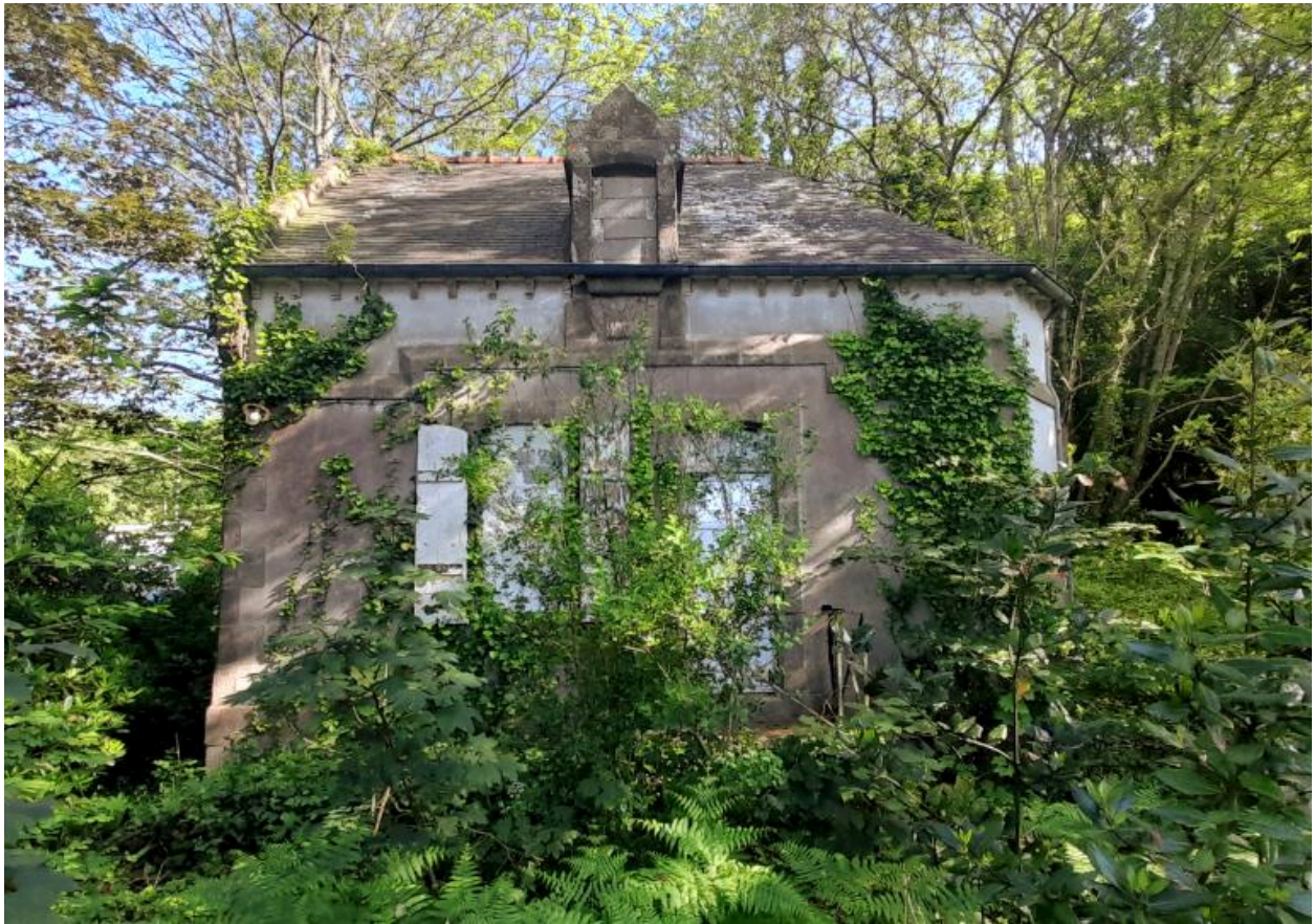
Maison de garde à l'entrée sud du domaine, élévation sud. (2023)
