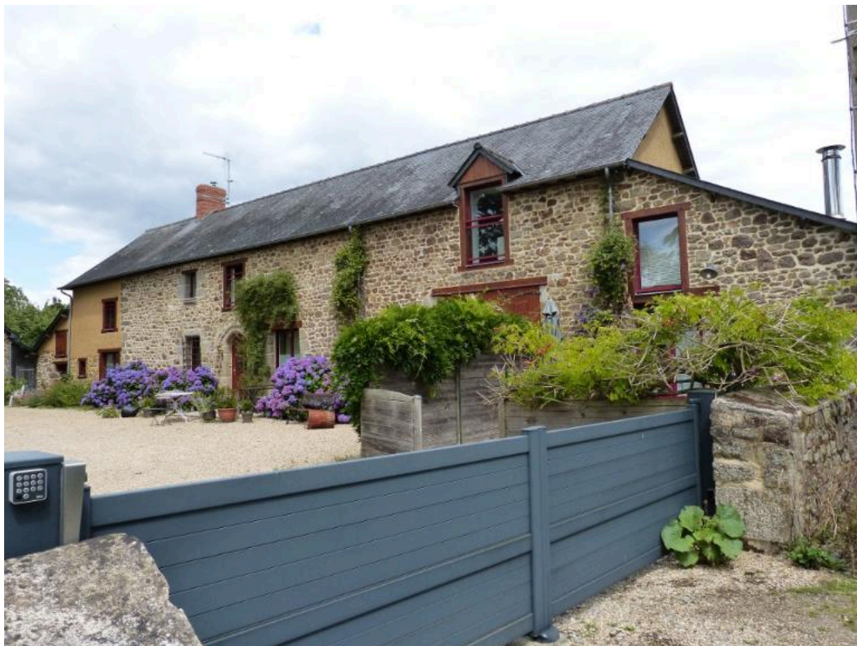
Vue générale sud ouest, Ferme, Bêlême (Hédé-Bazouges)
