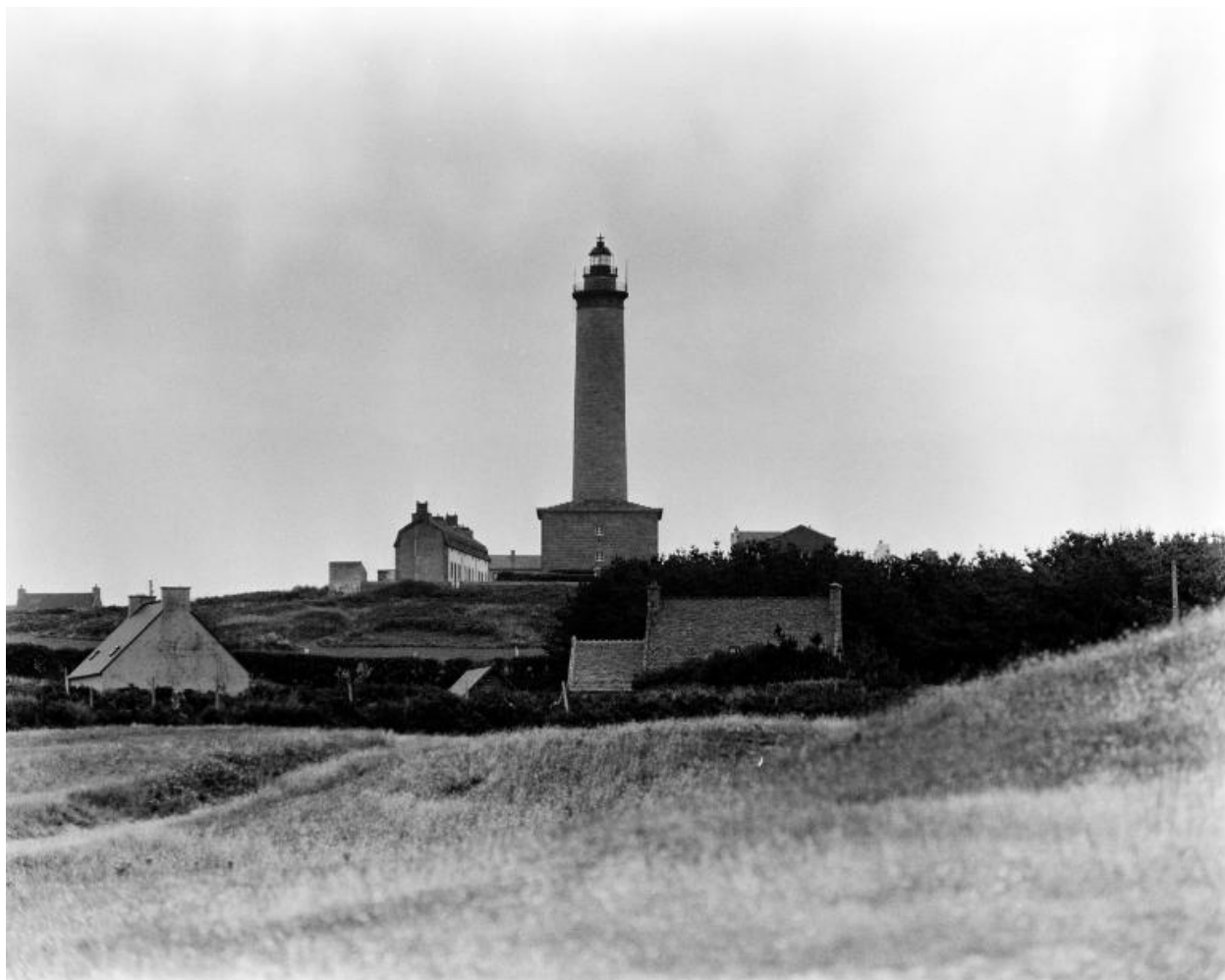
Vue de situation de l'ensemble
