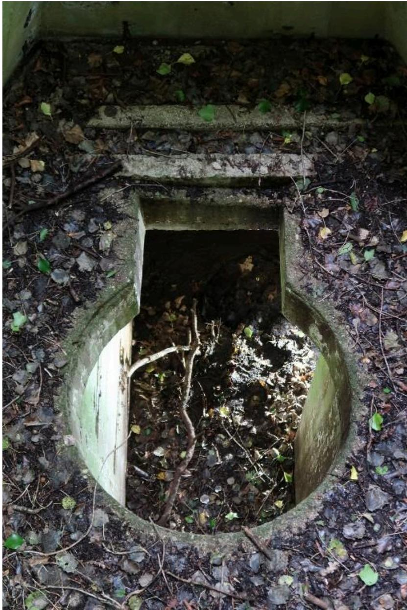
Vue de l'emplacement de la cloche blindée depuis l'extérieur. Ce bunker aurait dû être doté d'une cloche blindée de type 89P9
