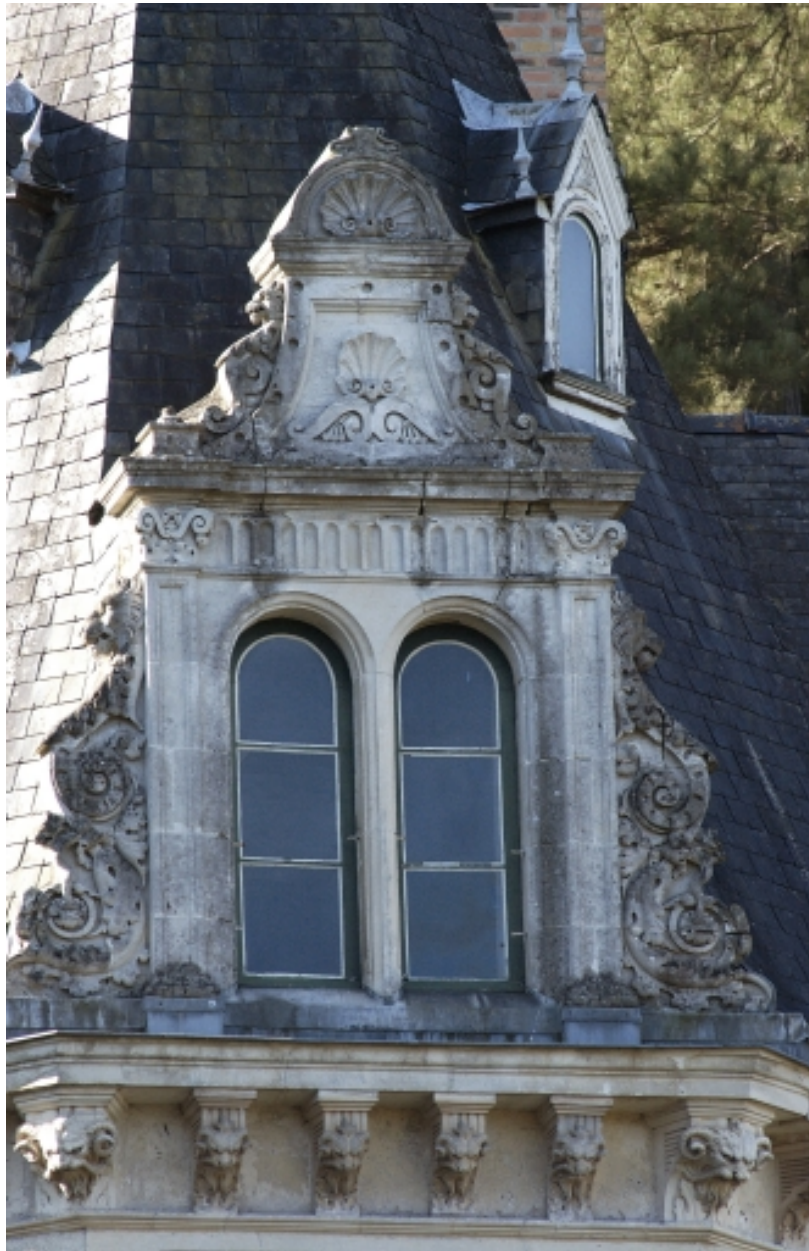
Façade nord : détail de la lucarne sur la tourelle
