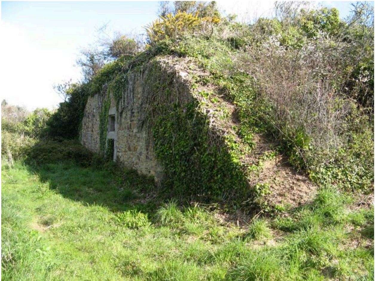
Elément de la batterie de Pont-Scorff
