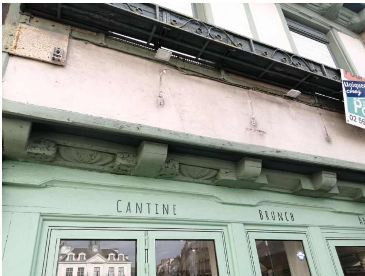
Détail des sablières d'encorbellement moulurées
