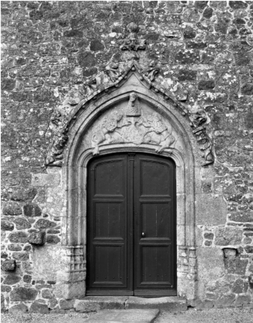
Elévation sud, porte : vue générale
