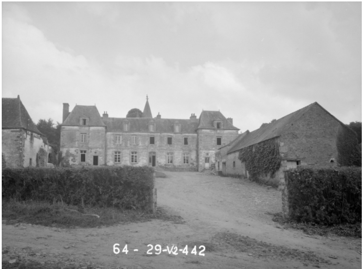
Vue générale prise du sud-ouest
