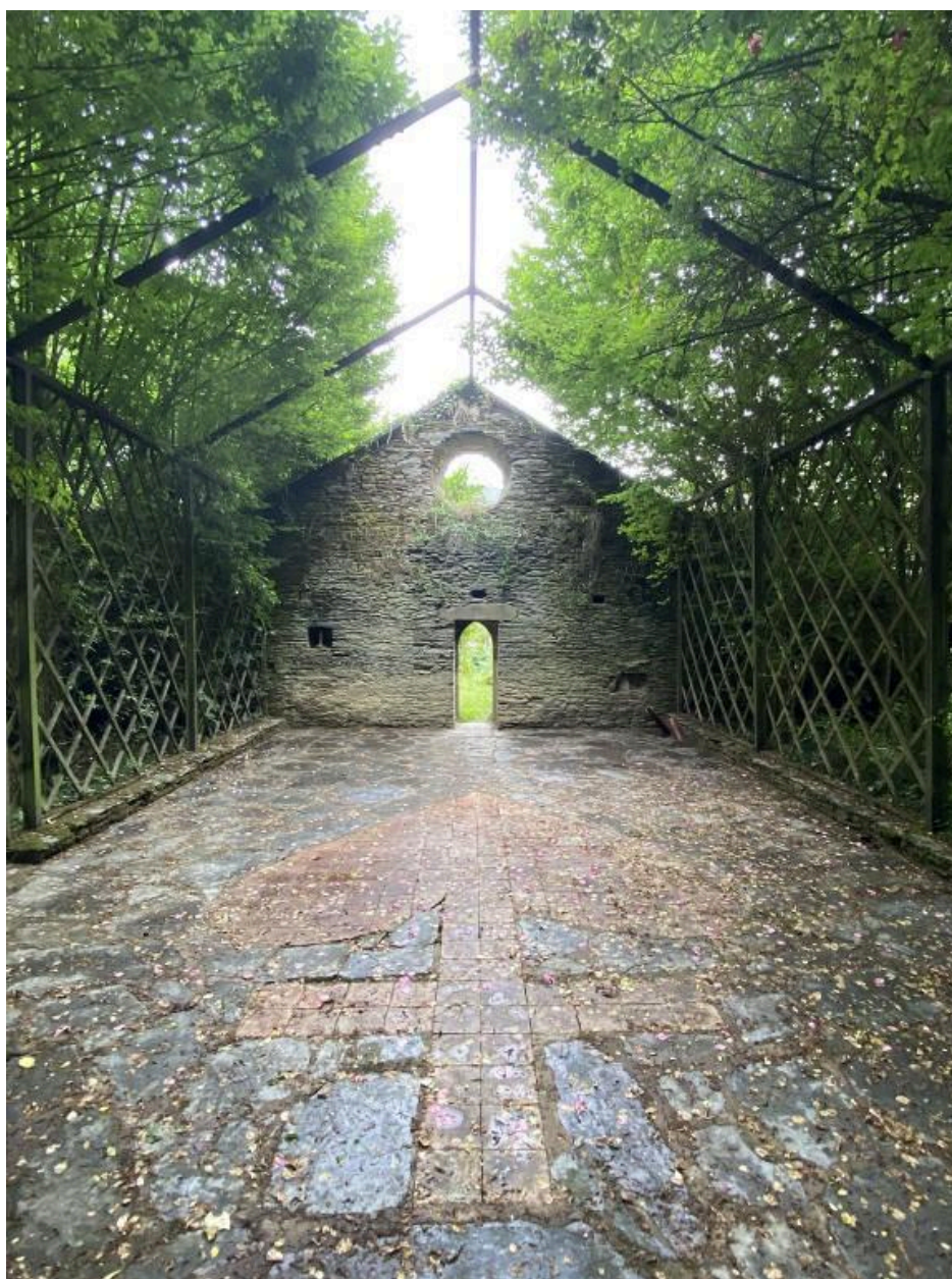
Ancienne chapelle, vue générale ouest
