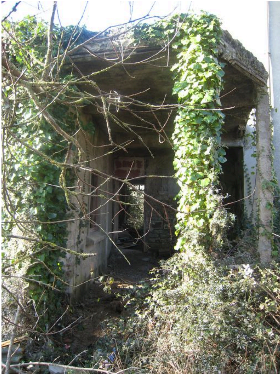
Détail à l'arrière de la villa Bellevue
