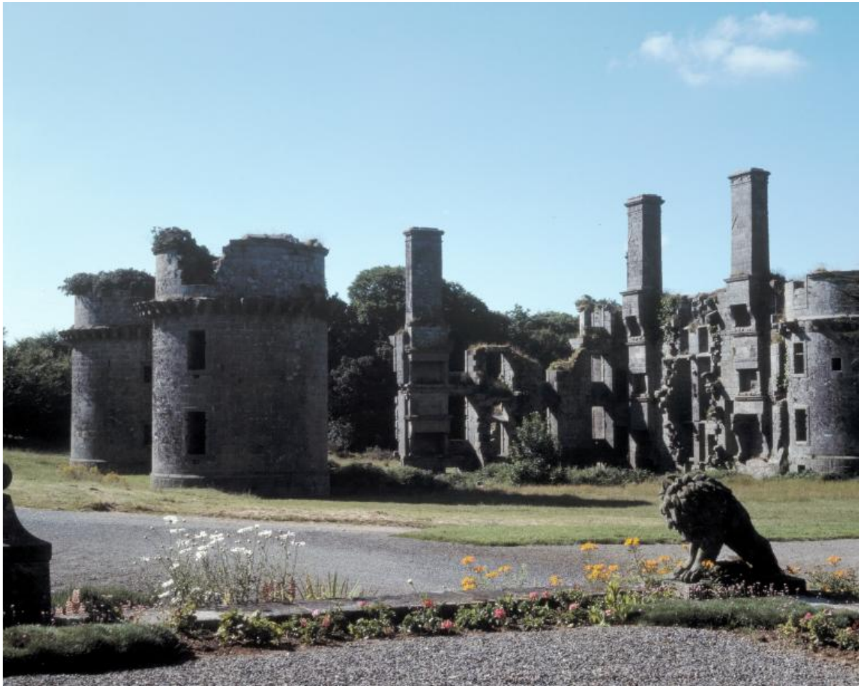
Vue générale depuis le nord et la terrasse du logis (état en 1986). Au premier plan, l'un des lions qui ornent le jardin
