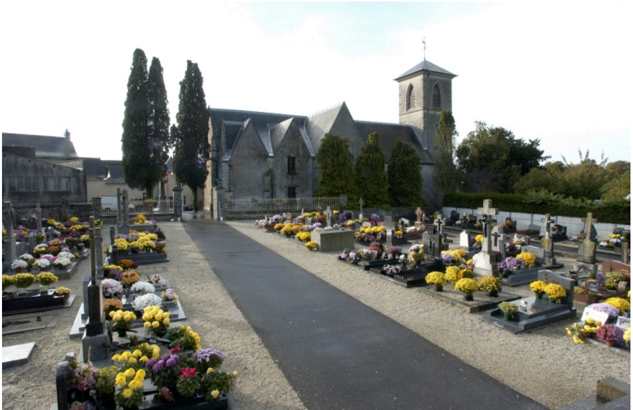
Vue générale nord
