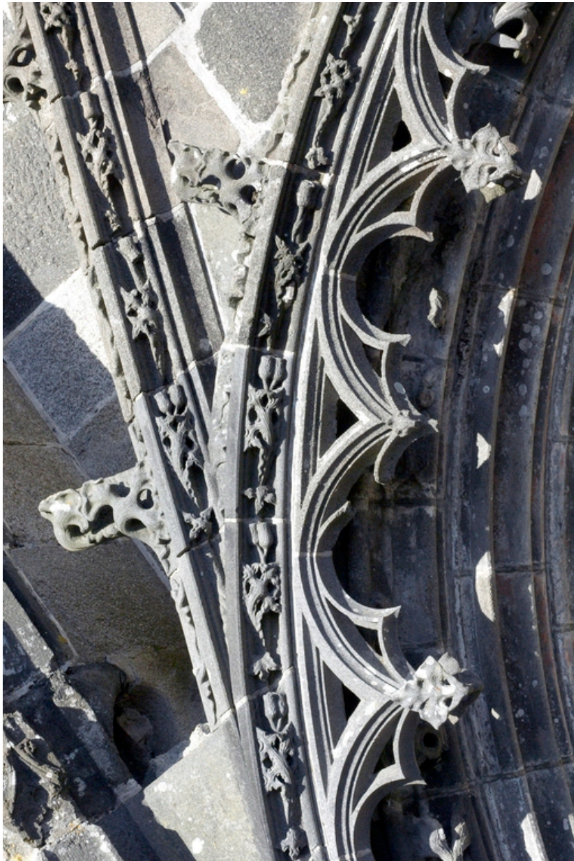
Détail du gâble du portail sud
