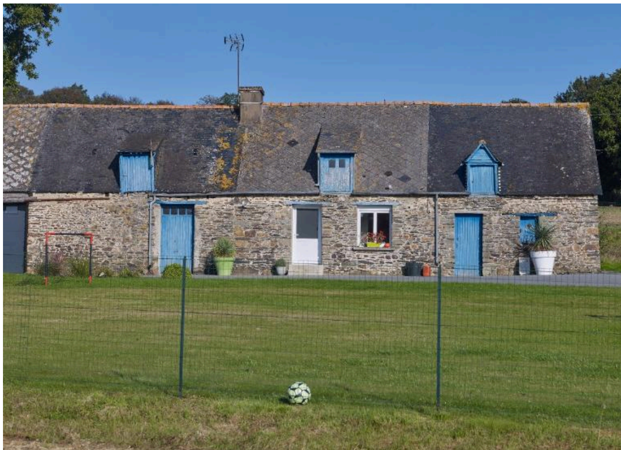
Alignement, avec le logis inclus entre le cellier et une autre dépendance. Vue sud
