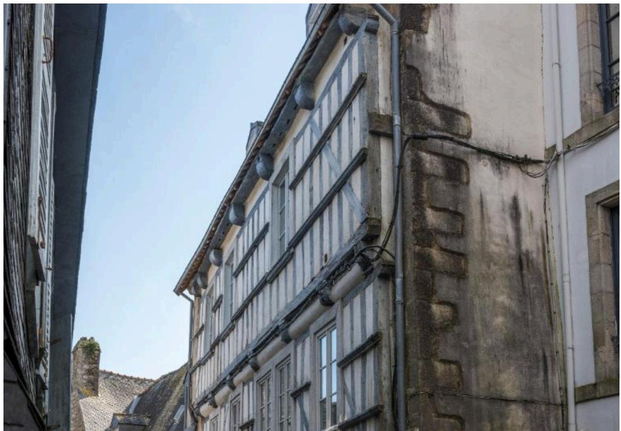
Des lisses hautes et basses filent sur l'étage, lequel est contreventé par des poteaux et écharpes.
