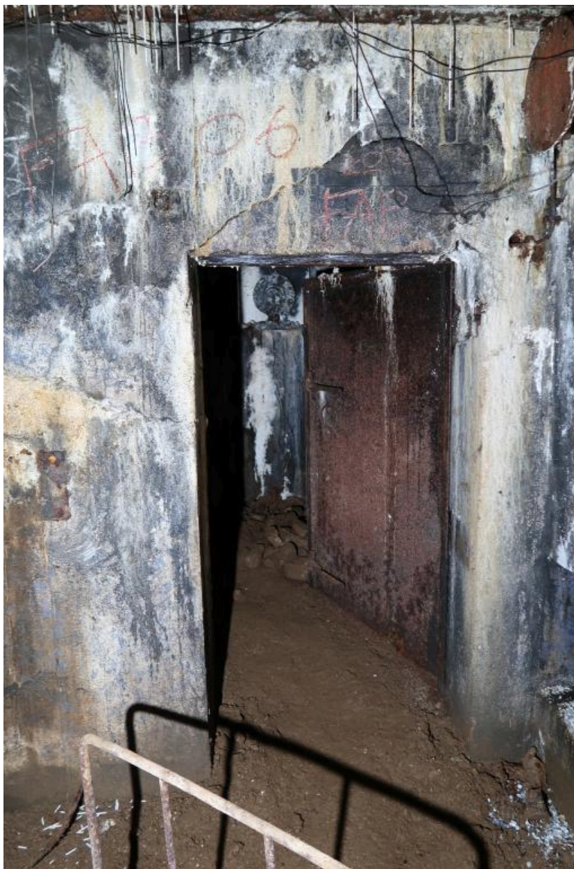
Vue de la porte étanche de la pièce de vie - chambre de troupe
