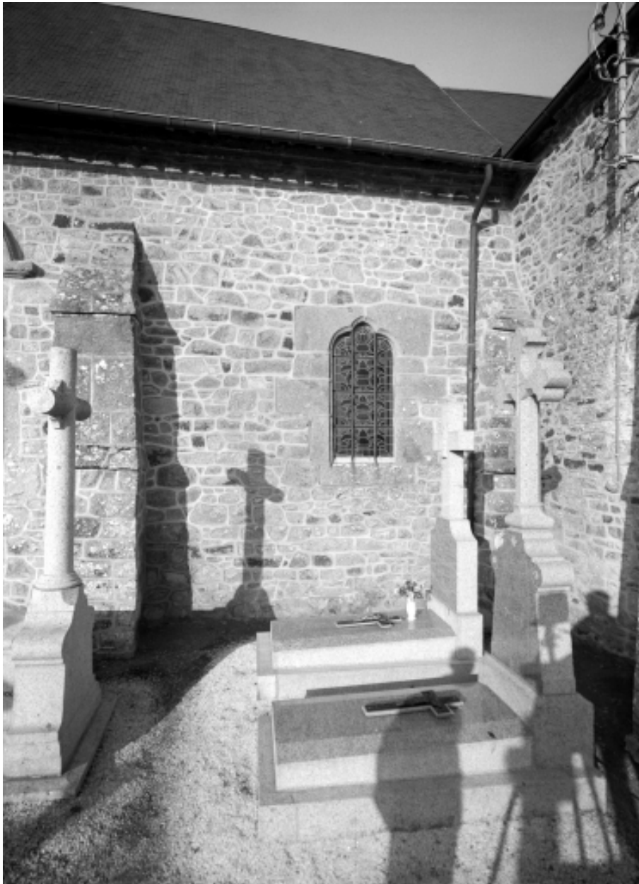
Elévation sud, fenêtre est : vue générale
