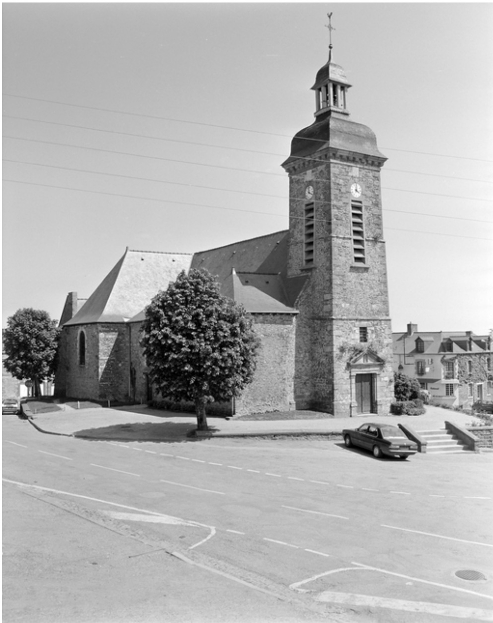
Elévation Nord-Ouest : vue générale
