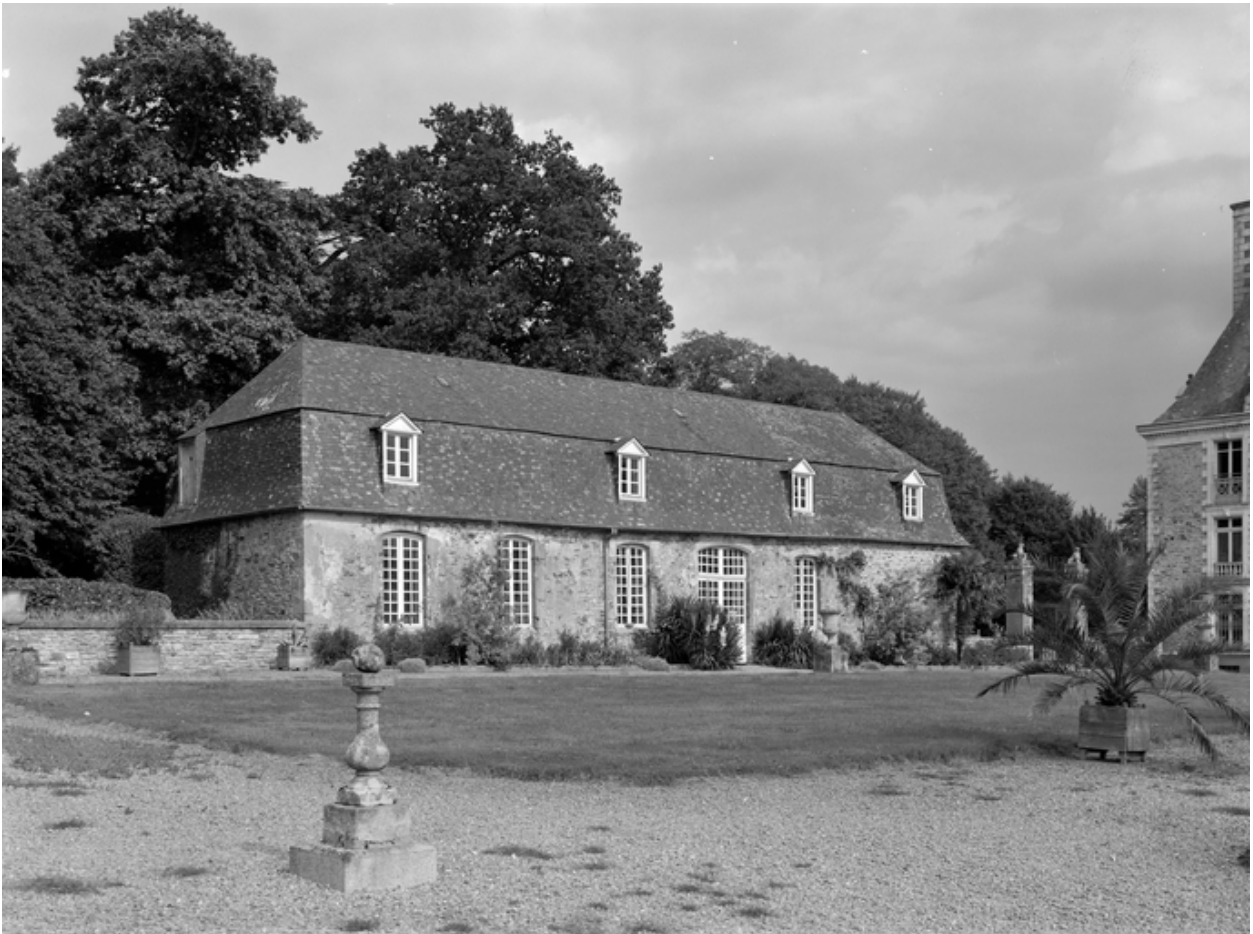
Vue générale de l'orangerie.
