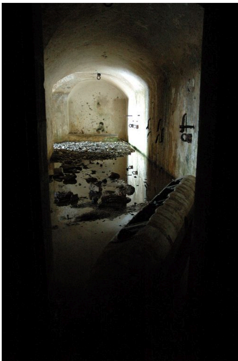
Vue du couloir de circulation (état en 2007)
