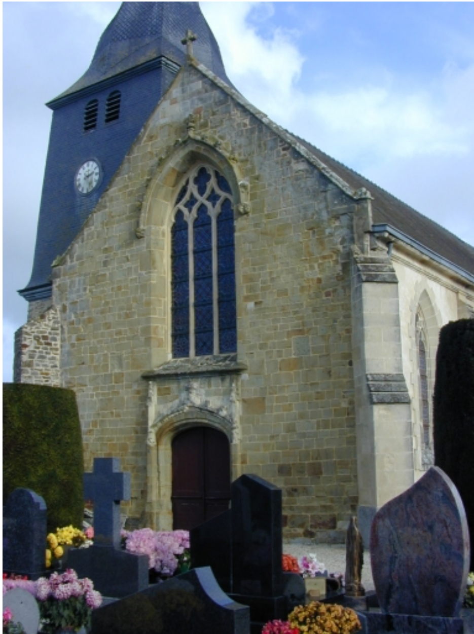
La façade occidentale : vue générale sud-ouest
