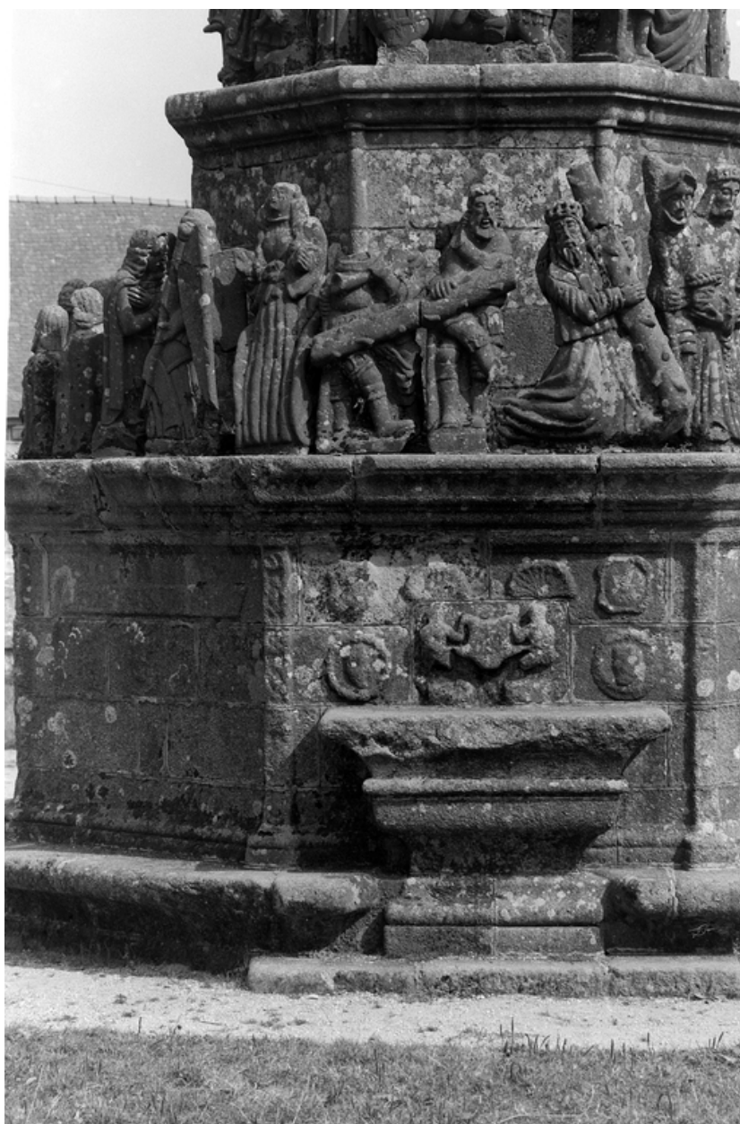
Face ouest, 1er socle : vue générale
