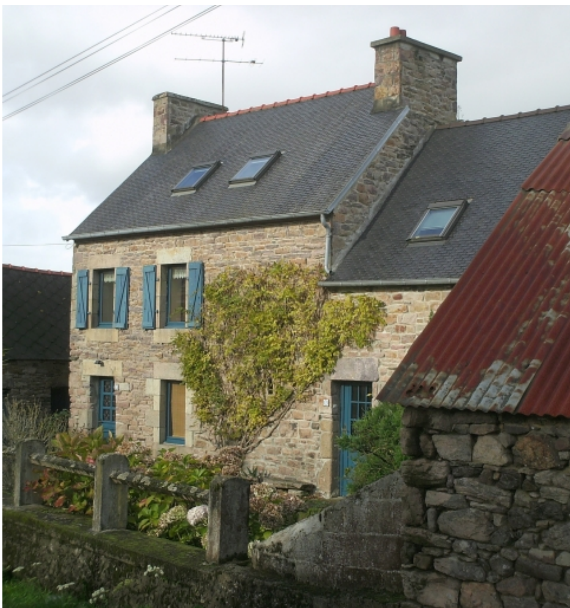
Paimpol, le Vieux-Bourg. Exemple d'habitat traditionnel : maison haute à deux travées (2ème moitié du 19ème siècle)
