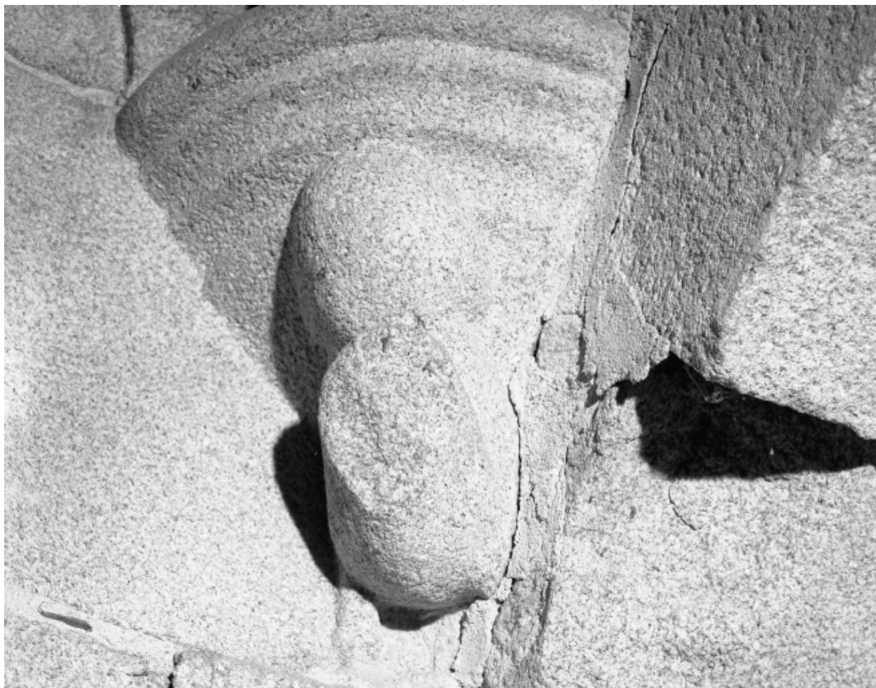
Escalier, 2ème repos du rez-de-chaussée : détail du cul-de-lampe nord ouest
