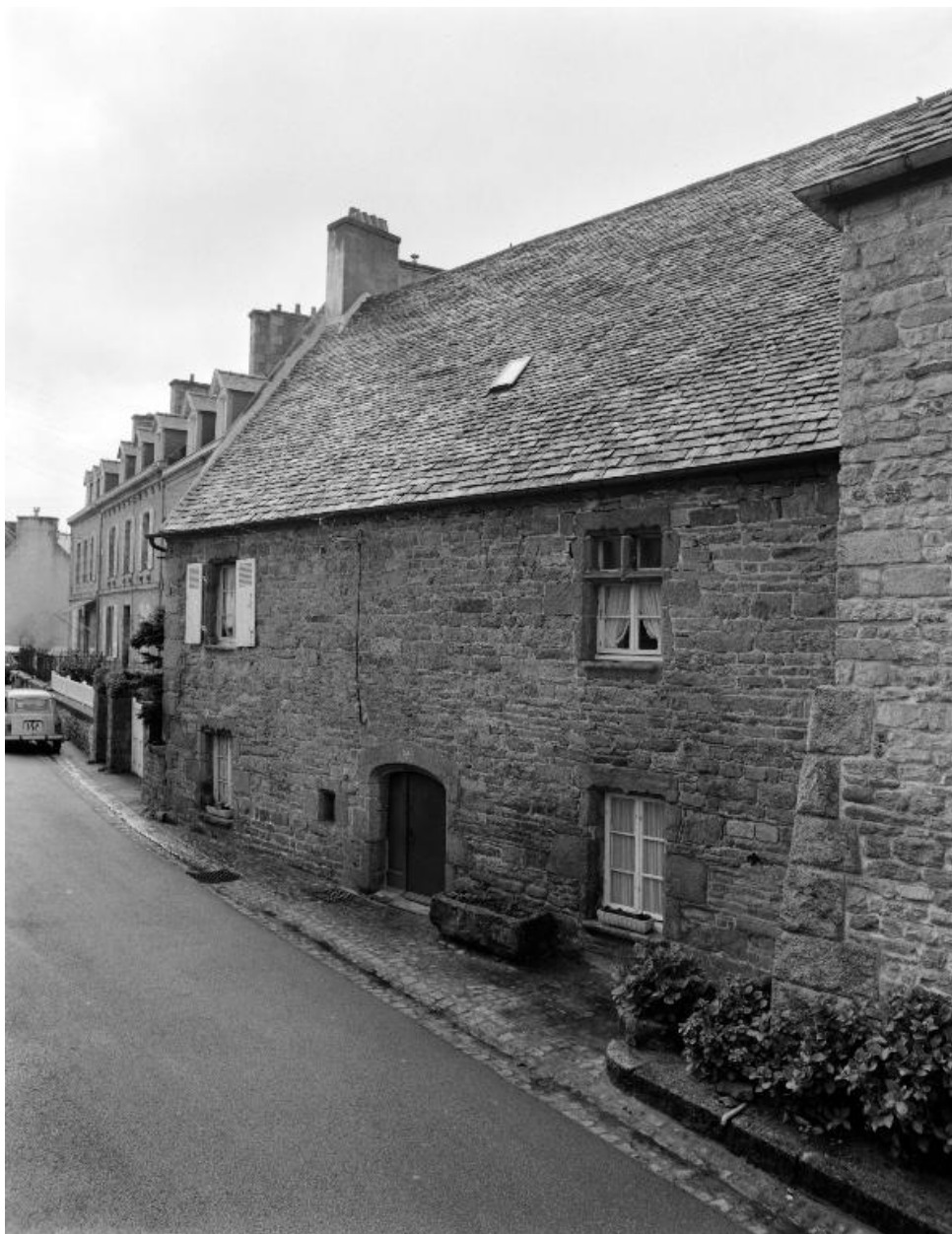
24 rue Joseph Viala, élévation nord, vue générale
