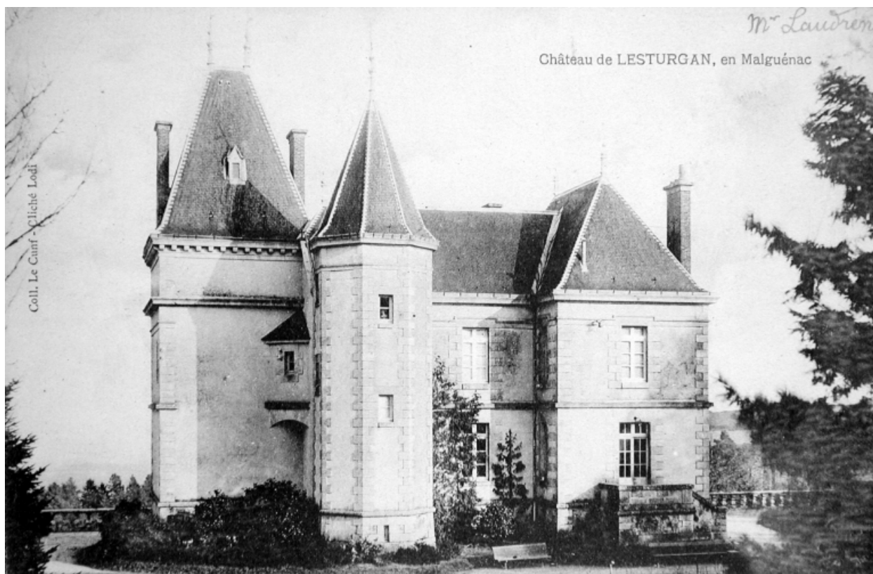
Vue générale de la façade postérieure
