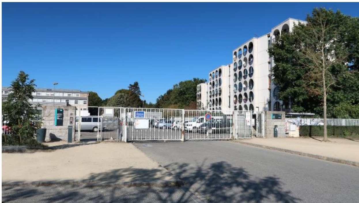
Grille en fer forgé de Raymond Subes, vers 1968-1969 : vue d'ensemble et de situation.
