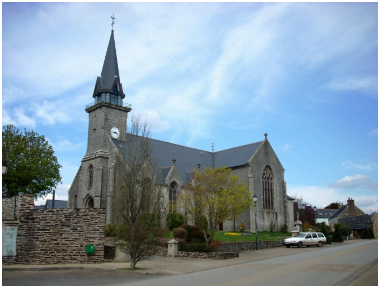
Saint-Goazec, église paroissiale : vue générale sud-ouest
