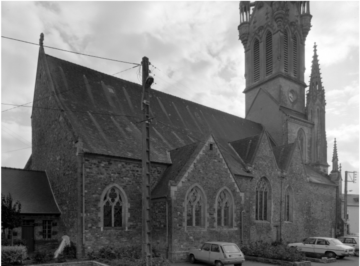
Elévation nord, vue générale.
