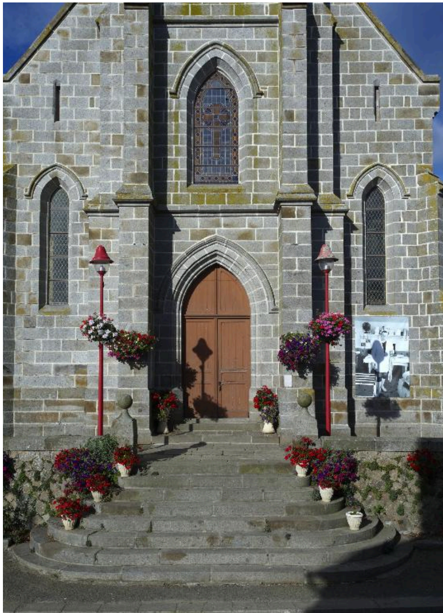
Détail de la façade
